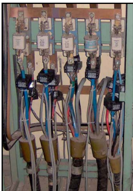
Slika 10. Osmokanalni MIS postavljen u TS 10/0.4 kV
