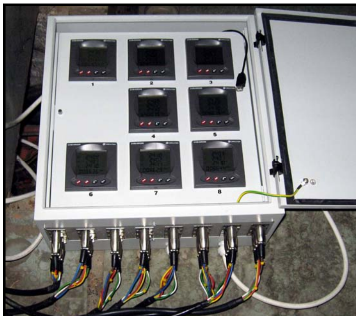
Slika 10. Osmokanalni MIS postavljen u TS 10/0.4 kV
